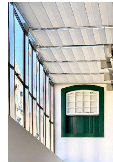
Figura 26 - Cobertura de vidro. Sobrado luso-brasileiro, construído na década de 1950, antes da intervenção.
